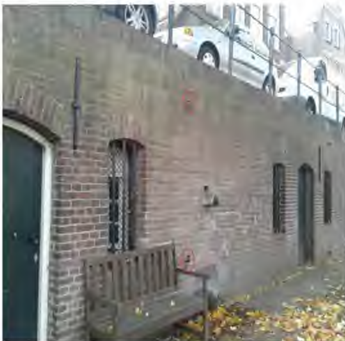
Figuur 3.2: Voorbeeldfoto positie prisma's (rood omcirkeld)
